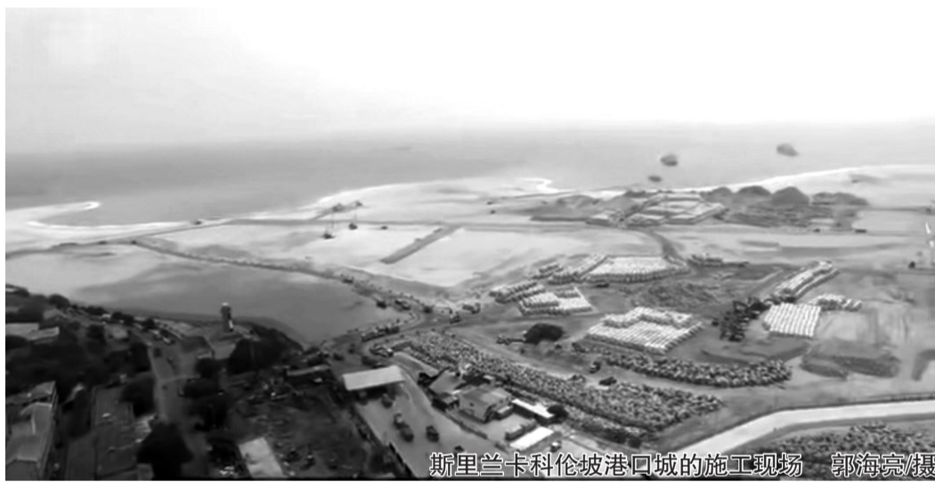
斯里兰卡科伦坡港口城的施工现场 郭海亮/摄
