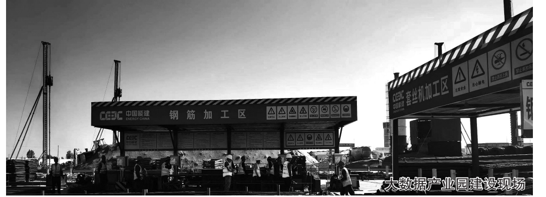
大数据产业园建设现场
