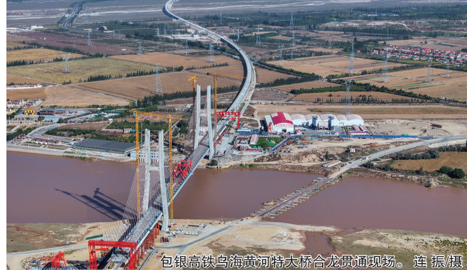
包银高铁乌海黄河特大桥合龙贯通现场。连振摄
